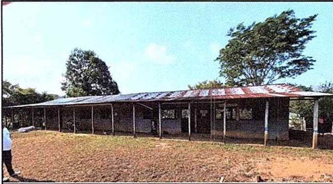
Foto 1: CORRECTIVO DE PARED Y SUSTITUCION DE LAMINAS
