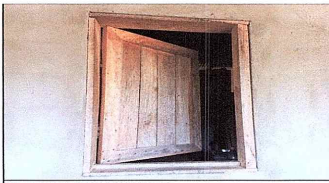
Foto 5: SUSTITUCION DE VENTANAS.
